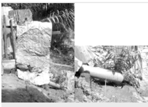
Figure 11 - Evacuation d'une latrine directement dans l'environnement, à proximité d'un puits. Le médaillon détaille le tuyau d'évacuation.
