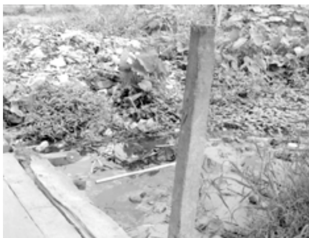
Figure 9 - Accumulation d'ordures et d'eaux boueuses dans un drain, et prolifération de végétaux aquatiques.
