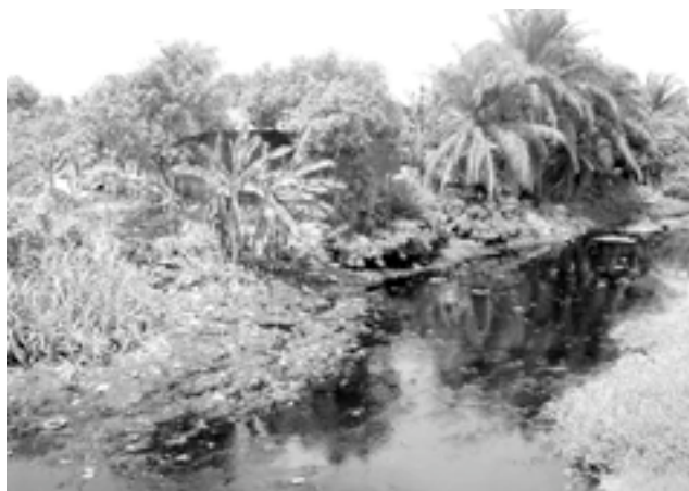
Figure 8 - Stagnation d'eaux et de boues dans les grands drains à ciel ouvert.
