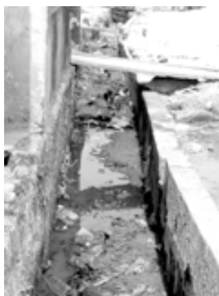
Figure 7 - Les eaux usées sont évacuées directement sans traitement préalable dans les drains.
