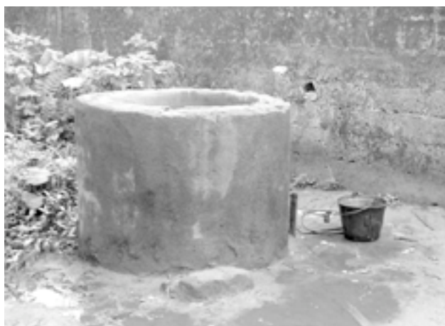
Figure 1 - Puits d'eaux superficielles (1,50 m de profondeur) à ciel ouvert dans un quartier de Douala.
